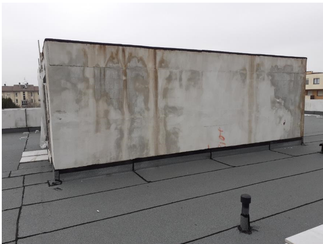
21 LOCALE TECNICO SUL CEPERTO – Si evidenziano le particolari condizioni di degrado dell'intonaco
