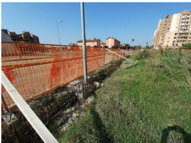
17 RECINZIONE – recinzione perimetrale. E' stato eseguito solo il cordolo di base
