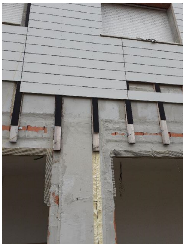
10 DETTAGLIO – rivestimento da smontare
