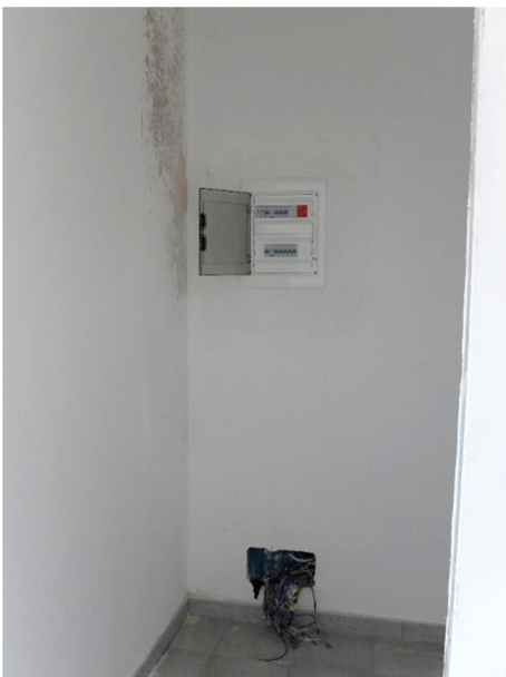
31 DETTAGLIO – scatola elettrica senza coperchio
