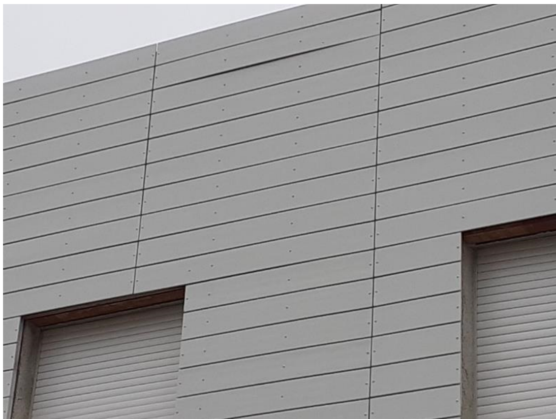
9 DETTAGLIO – rivestimento da smontare
