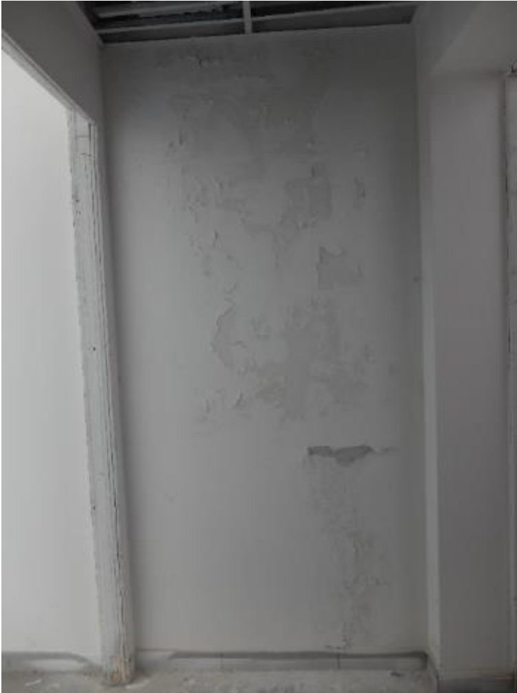
30 DETTAGLIO Una parete della scala della foresteria con l'intonaco marcio da rimuovere e rifare
