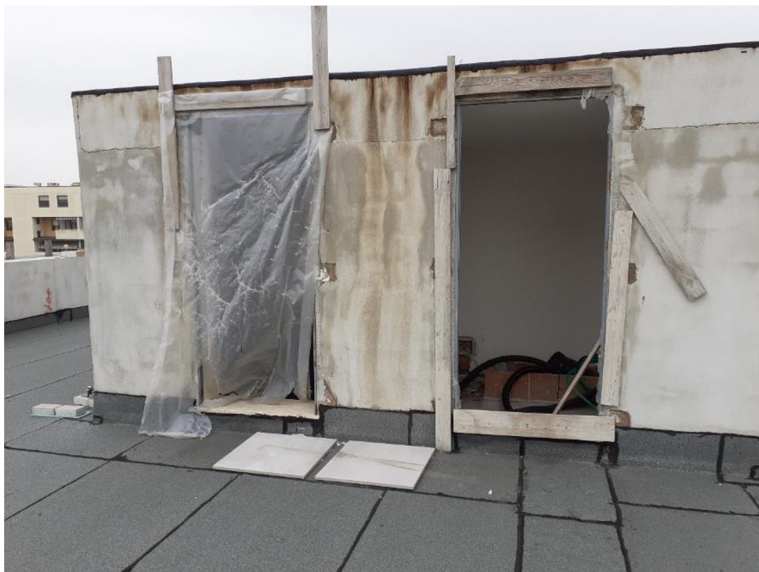
20 LOCALE TECNICO SUL CEPERTO – Si evidenziano le particolari condizioni di degrado dell'intonaco
