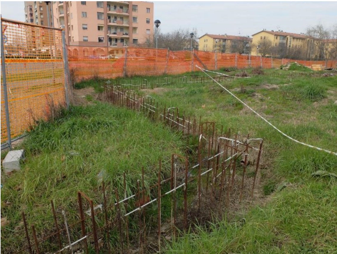
15 RECINZIONE – recinzione perimetrale. E' stato eseguito solo il cordolo di base
