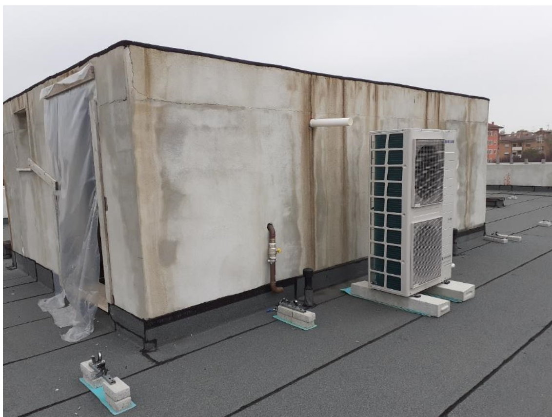
19 LOCALE TECNICO IN COPERTURA – si evidenzia l'asportazione delle tubazioni in rame da parte di ladri
