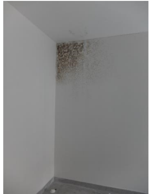
30 DETTAGLIO Una parete della scala della foresteria con l'intonaco marcio da rimuovere e rifare
