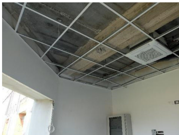
28 A SINISTRA – La predisposizione per un lo split nelle stanze della foresteria – mancano le tubazioni del gas refrigerante, lo scarico di condensa e l'allacciamento elettrico
