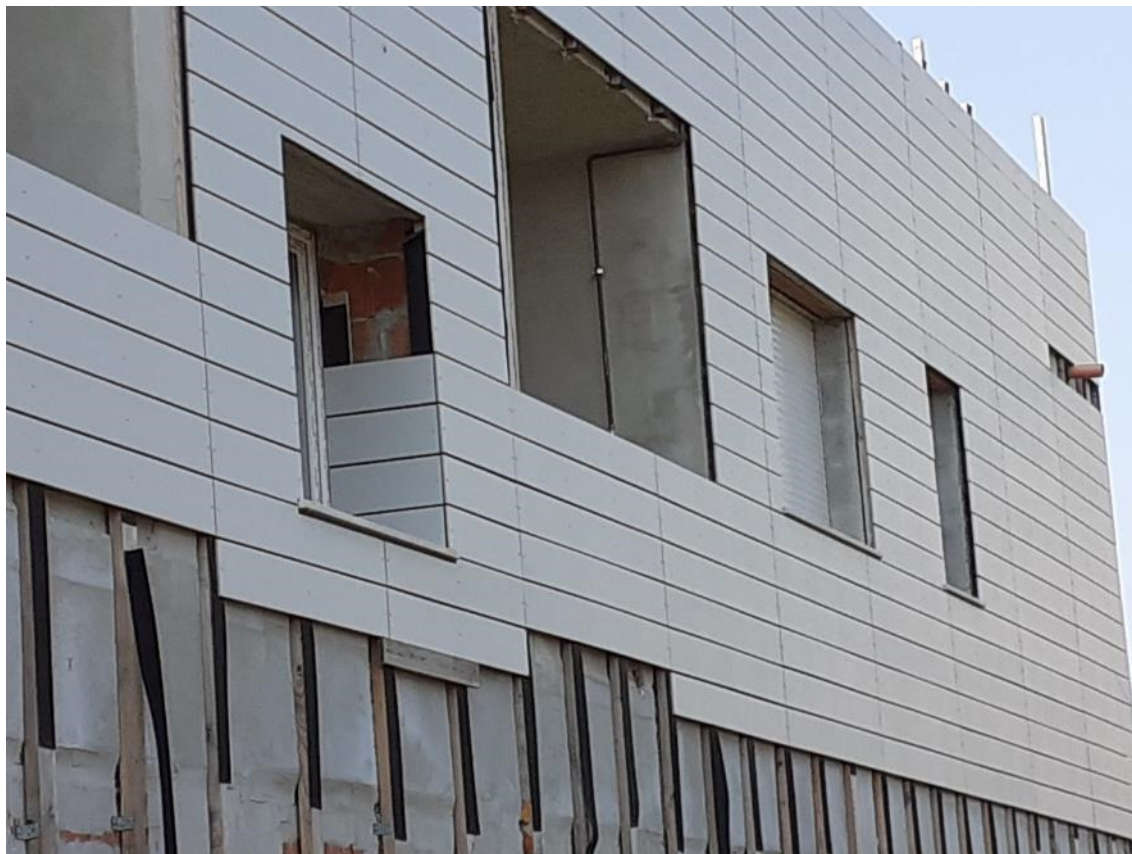
6 VISTA DA EST - il rivestimento delle spallette è incompleto
