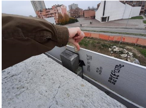
12 DETTAGLI – listelli e doghe del rivestimento da smontare
