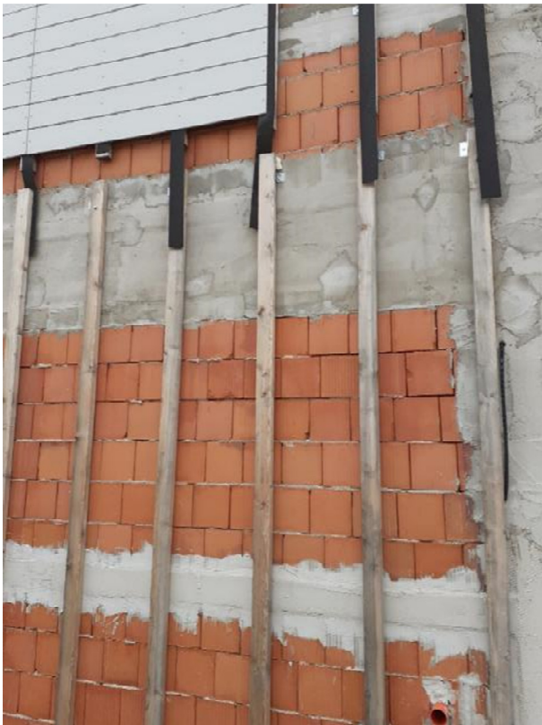
11 DETTAGLI - – listelli del rivestimento da smontare
