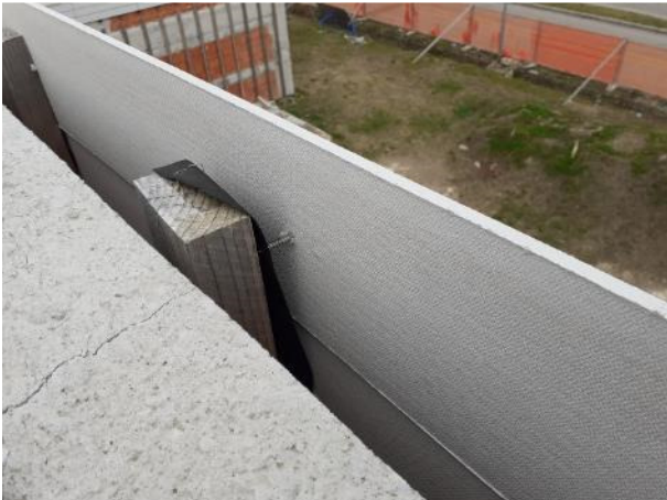
12 DETTAGLI – listelli e doghe del rivestimento da smontare
