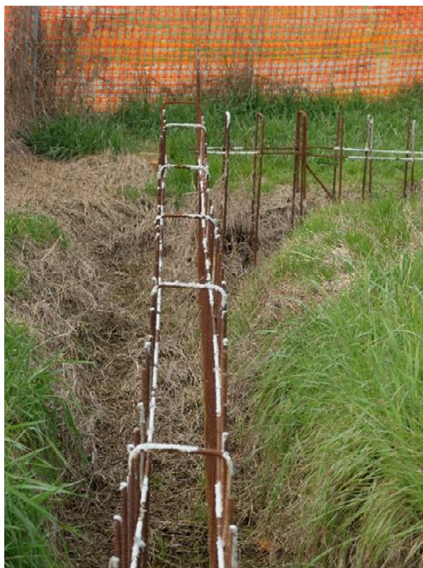
17 RECINZIONE – recinzione perimetrale. E' stato eseguito solo il cordolo di base
