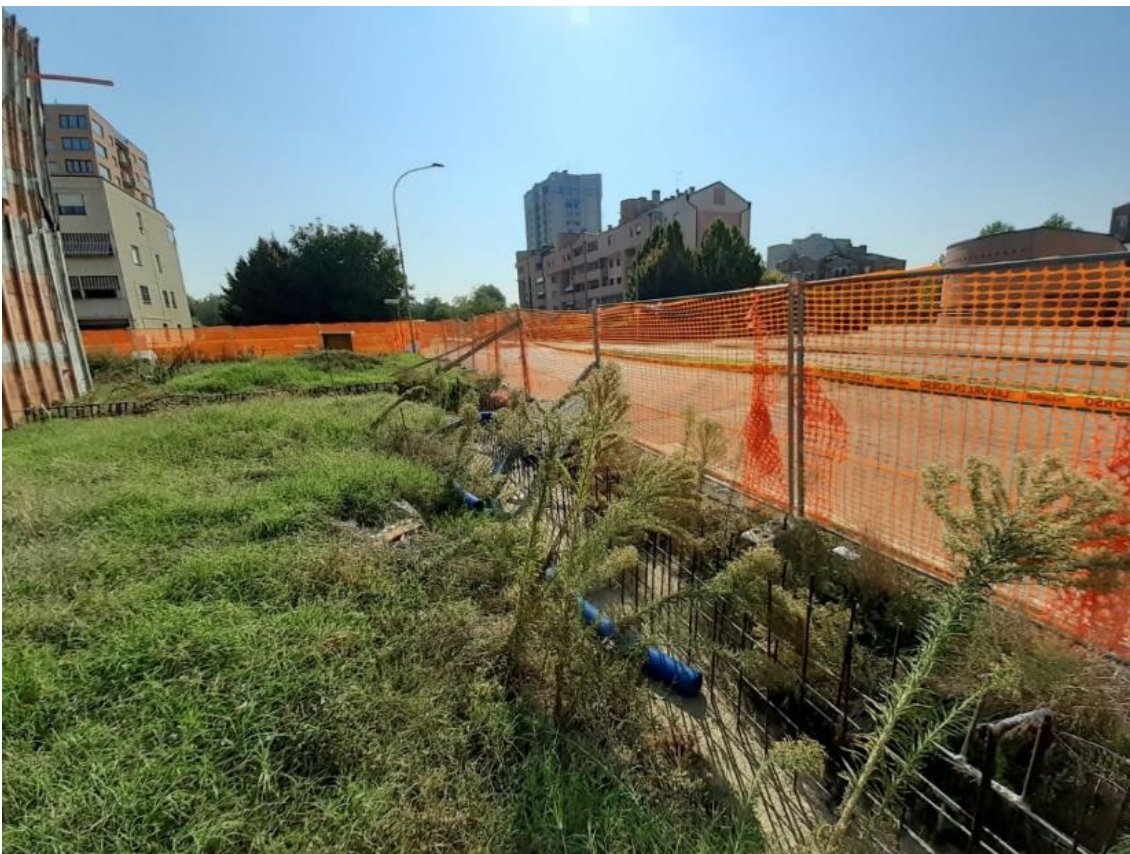
16 RECINZIONE – recinzione perimetrale. E' stato eseguito solo il cordolo di base
