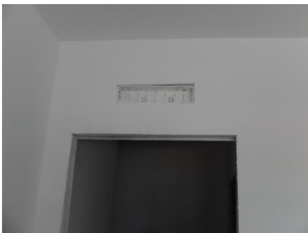
28 A SINISTRA – La predisposizione per un lo split nelle stanze della foresteria – mancano le tubazioni del gas refrigerante, lo scarico di condensa e l'allacciamento elettrico
